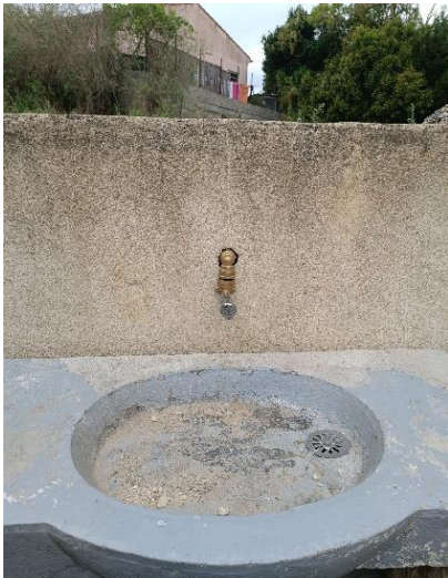
« Mise en place du point d'eau »
