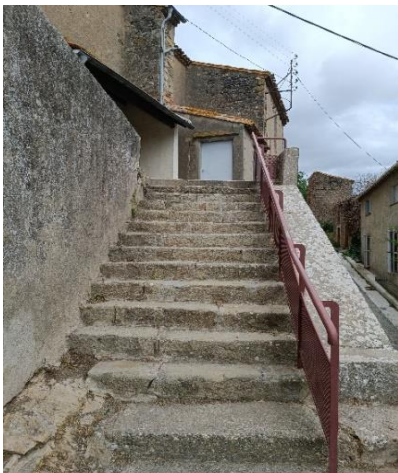
« Nettoyage des marches de l'église »
